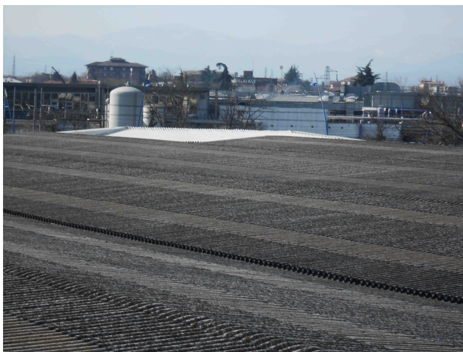
EDIFICIO N°5 Particolare lavori di manutenzione
